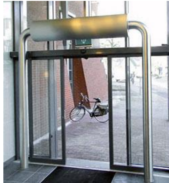
Afbeelding 20 Voorbeeld van een luchtgordijnsysteem
